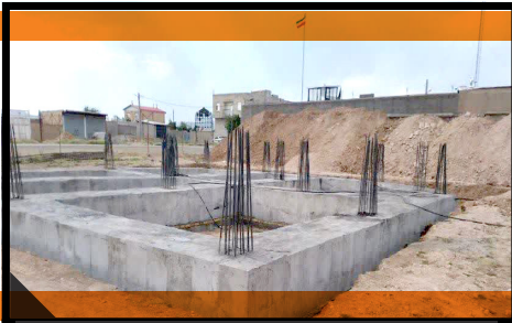
آغاز عملیات اجرائی ساختمان بخشداری بقراطی شهرستان رزن
