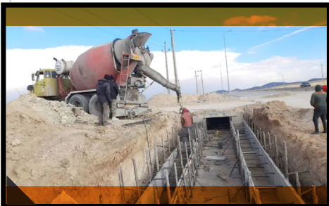
اجرای عملیات بتن ریزی پی پل سه راه خنجرآباد
