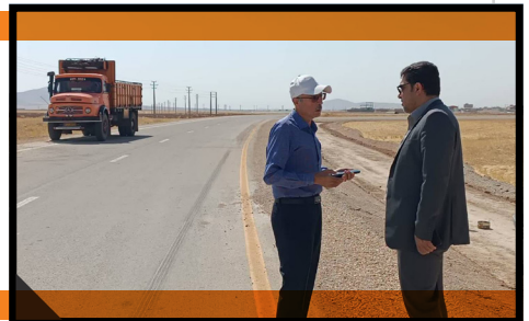
بازدید از کنارگذر رزن دهمق
